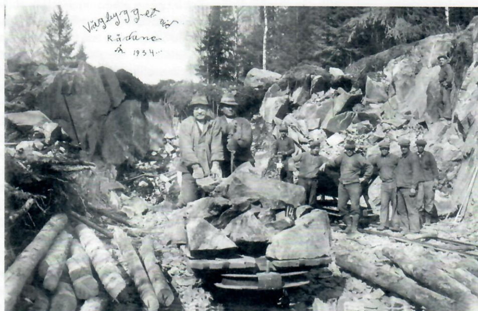
Ett arbetslag bygger ny väg vid Rådane i Ödeborg, år 1934. En artikel om våra vägar förr och nu inleder detta nummer av tidningen. (Foto okänd)
